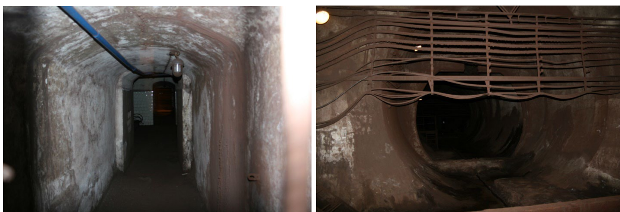
Рисунок 2.12 – Канализационная камера (слева) и вентиляционный тоннель (справа)
