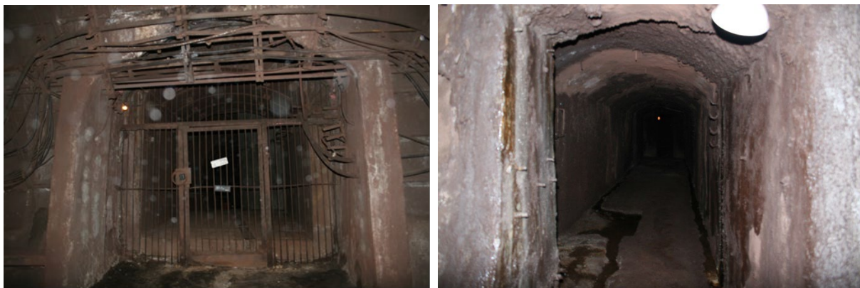
Рисунок 2.13 – Вентиляционный тоннель (слева) и ходок (справа)
